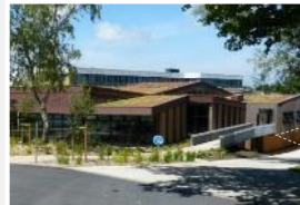
Lycée à Brest (29) – rénové 2019
